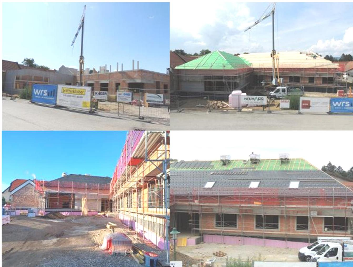
Der Baufortschritt liegt im Zeitplan. Die Arbeiten der Firma Bretterkrieger sowie die Zimmermanns- und Dachdeckerarbeiten sind weitgehend abgeschlossen, ebenso der Einbau sämtlicher Fenster. Im Oktober konnte als Danke für die ausführenden Firmen die Gleichfeier durchgeführt werden. Derzeit werden die Zwischenwände in Trockenbauweise sowie die Wasserinstallations- und Elektroinstallationsarbeiten durchgeführt.
