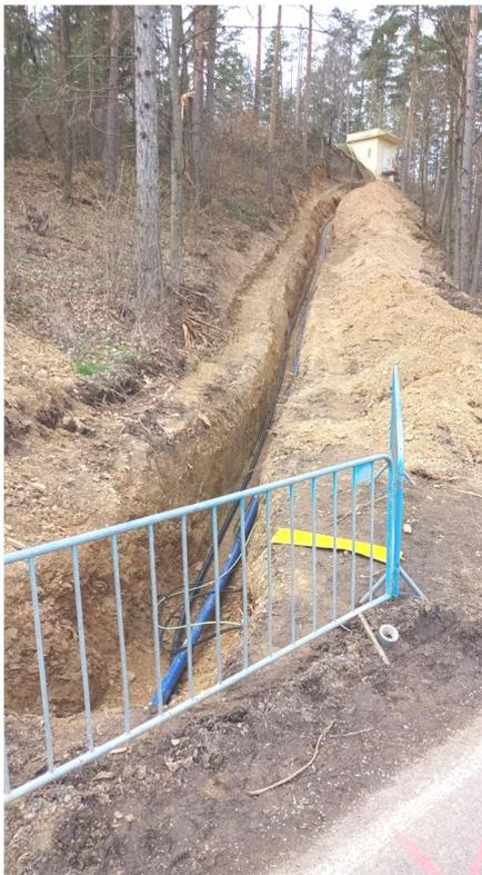
Die notwendigen Arbeiten zur Erneuerung der **Wasserleitung von der Quellstube bis zum Hochbehälter Gramatl** wurden im März 2024 abgeschlossen. Zusätzlich wurde ein Leerrohr für eine zukünftige Erneuerung der Abgabelleitung in das Ortsnetz, sowie die Stromversorgung und das Steuerungskabel mitverlegt.
