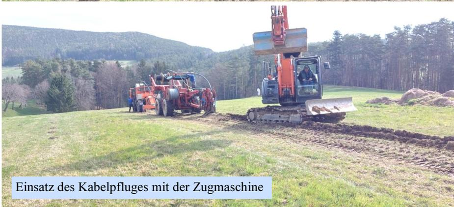
Einsatz des Kabelpfluges mit der Zugmaschine
