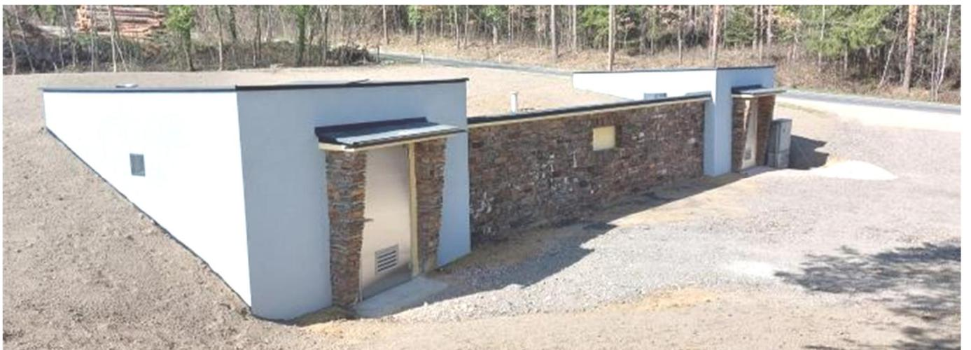
Die Außensanierung des Hochbehälters Straßhof wurde im März 2023 abgeschlossen. Die Innensanierung der vier Behälterkammern soll im Herbst 2023 erfolgen.
